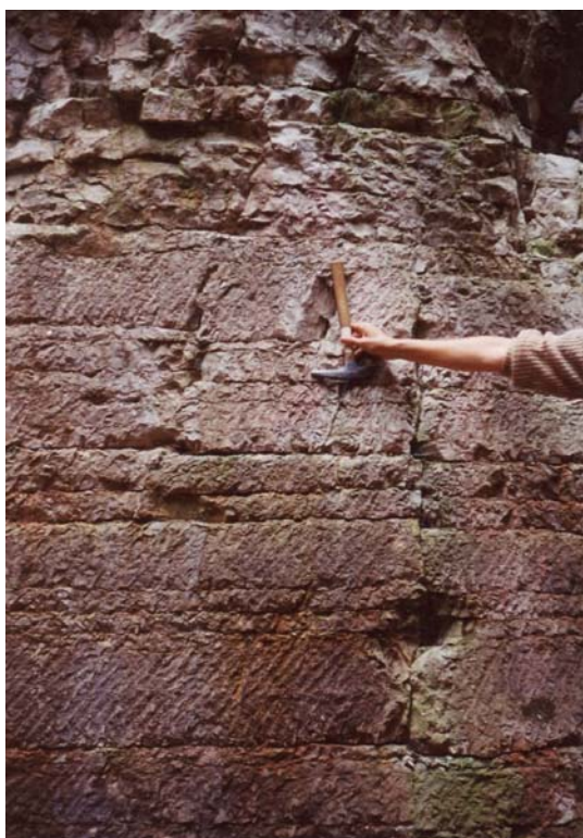
5. ábra Ritzelt fejtési nyomok a Bányahegyi-kőfejtő „vörös márvány” rétegein (Tardos, Gerecse-hegység)
