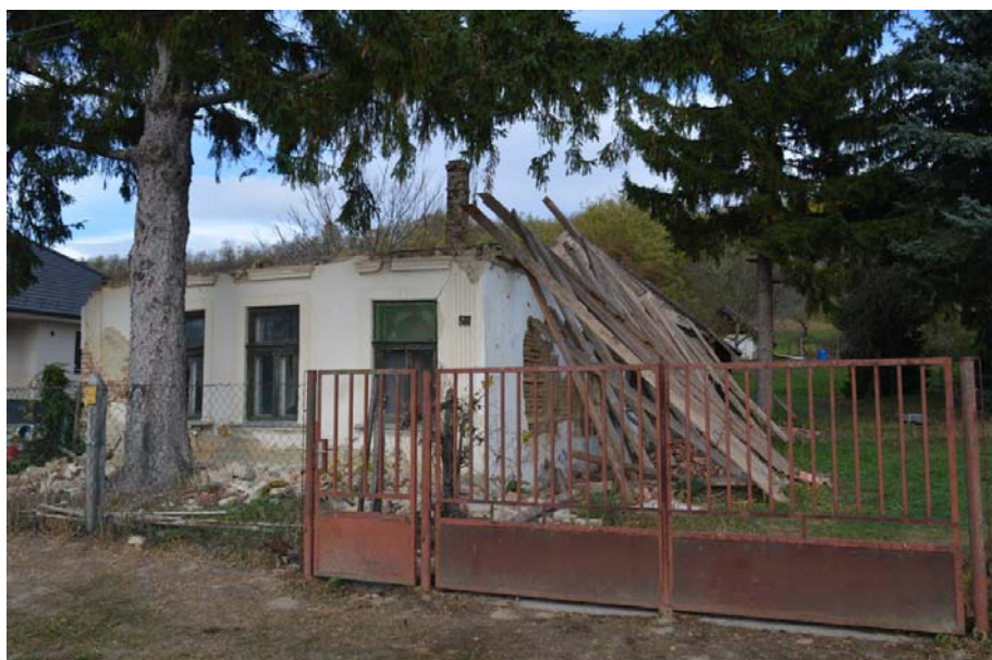
50. kép: A 2025. októberi bejáráson a 48. számú épületet éppen bontották (a szerző fotója).
