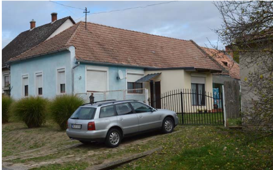
45. kép: Kossuth u. 16. Az egykori tornácot beépítették, de feltehetően az eredeti falszerkezet és nyílásrend megmaradt (a szerző fotója).
