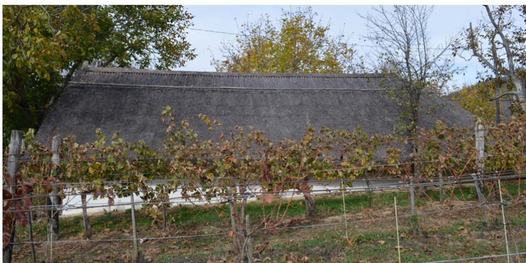
23. kép: A leglátványosabb változtatás a tetőidom módosítása. Az új nádfedés jól látható a képpáron (a szerző fotója).
